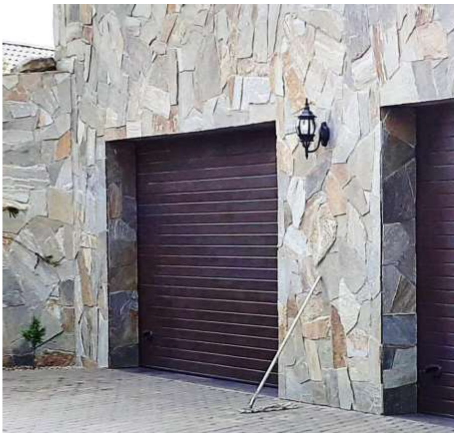
Рис. 2. Облицовка стен плитняком.
