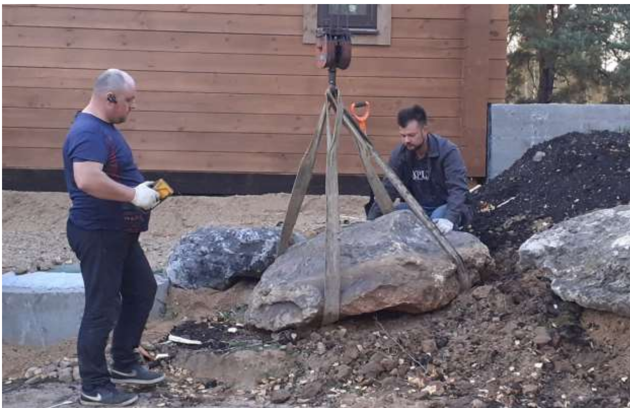
Рис. 9. Укладка степняков на объекте
