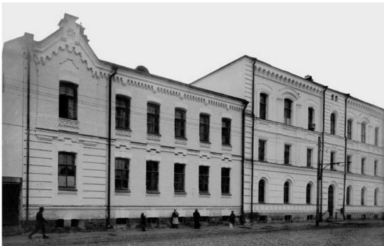
Рис. 14.а. Здание по ул. Трехсвятская 31/16.
